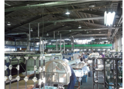
クリーニング工場 暑熱対策箇所
