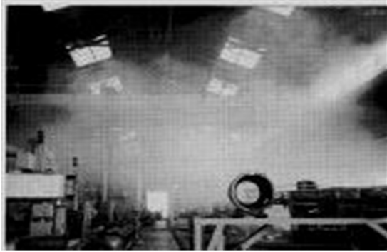
発煙テスト(換気設備の運転開始直前)
