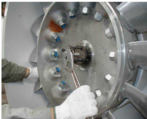
図5 ハブ 抜きによるファンロータ取外し
